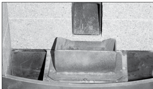
Figure 14 : Nettoyage de la boîte à feu
