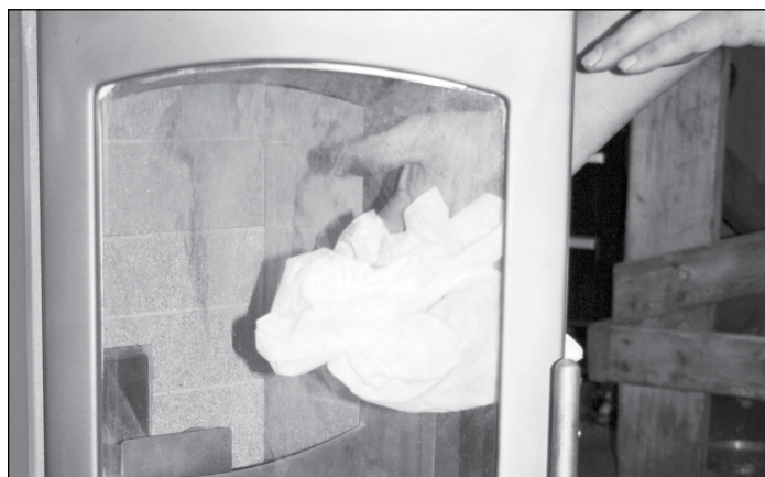
Figure 31 : Essuyer la vitre et contrôler le joint
